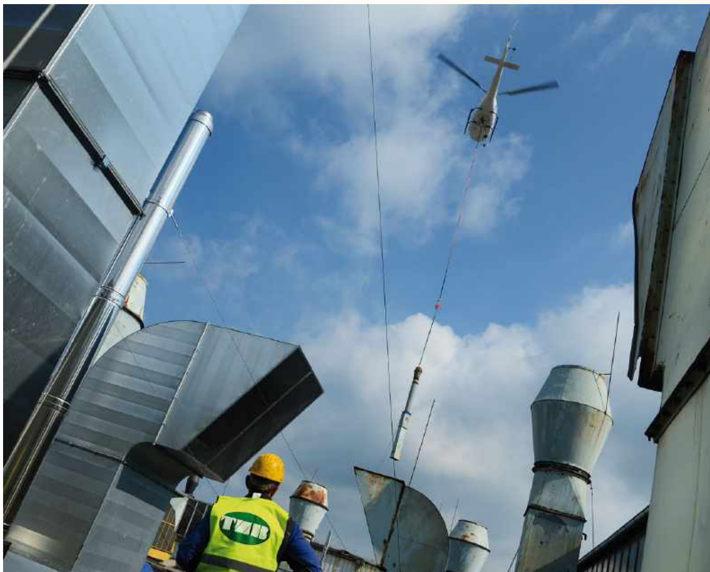
• V rozlehlých logistických nebo výrobních areálech jsou vrtulníky výbornou alternativou k použití jeřábové techniky
